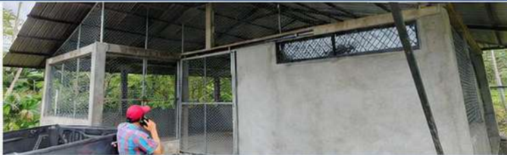
VENTANAS Y PROTECCIONES, MALLA Y TUBO HG 1"
