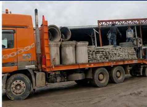
TRASLADO Y DESCARGA DE MATERIALES
